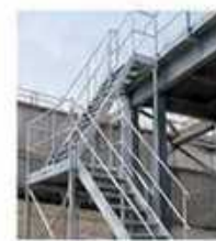
ESCALERAS FIJAS (UNE-EN ISO 14122:2017)
